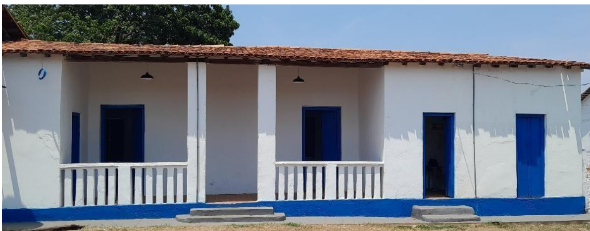
Figura 6 – Escola Municipal Otaviano Calmom – vista do fundo da Escola
