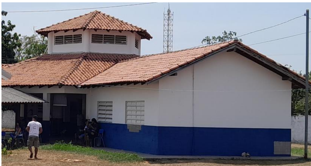
Figura 8 – Prédio II da Escola Estadual Indígena Julá Pará (fundos)
