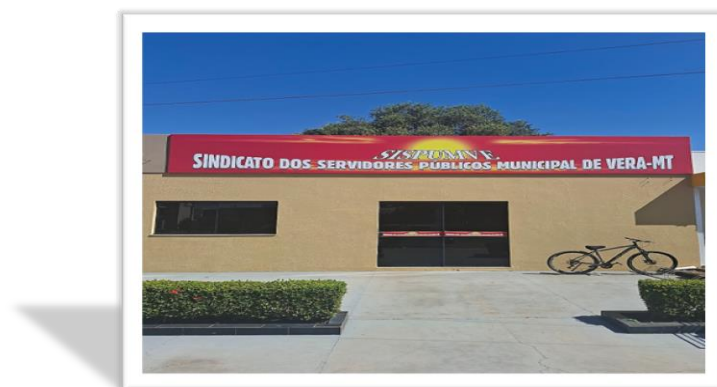
Figura 2 - Prédio atual do Sindicato dos Servidores Públicos Municipais de Vera-MT
