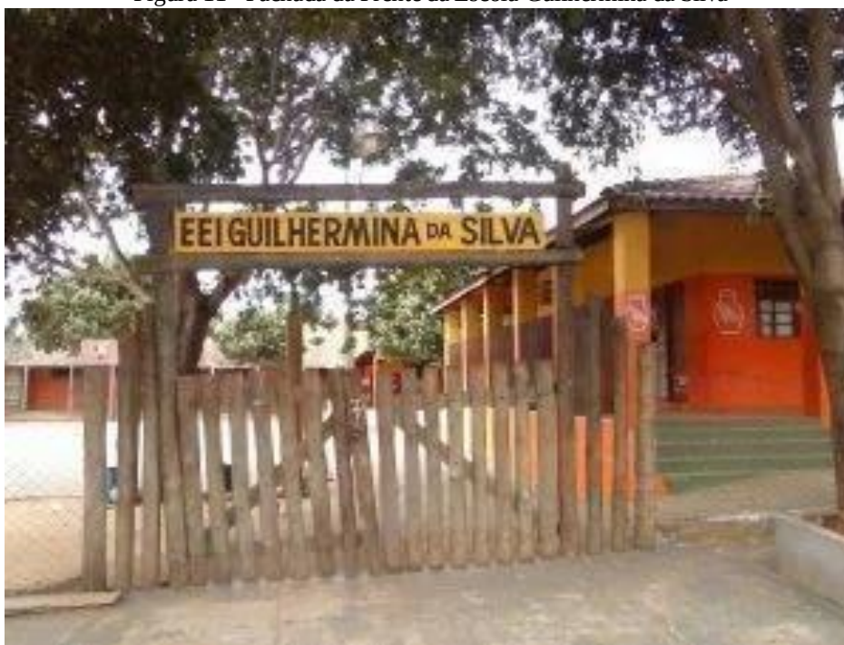
Figura 11 - Fachada da Frente da Escola Guilhermina da Silva
