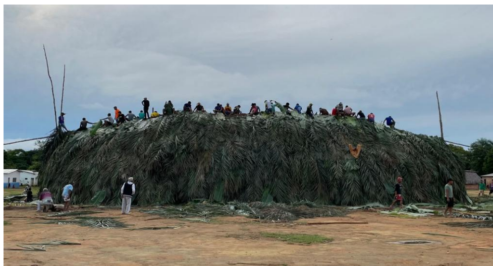
Imagem 03: Conclusão da construção da Takãra
