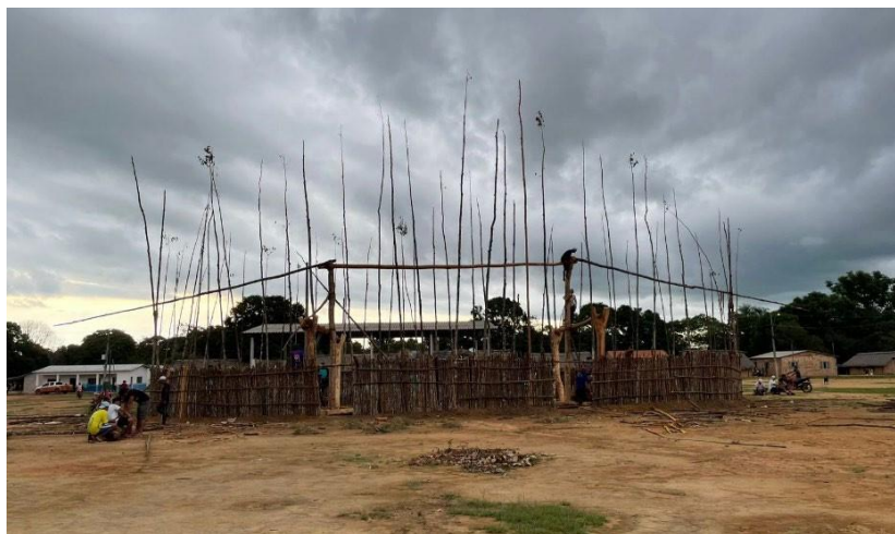
Imagem 02: Início da construção da Takãra.
