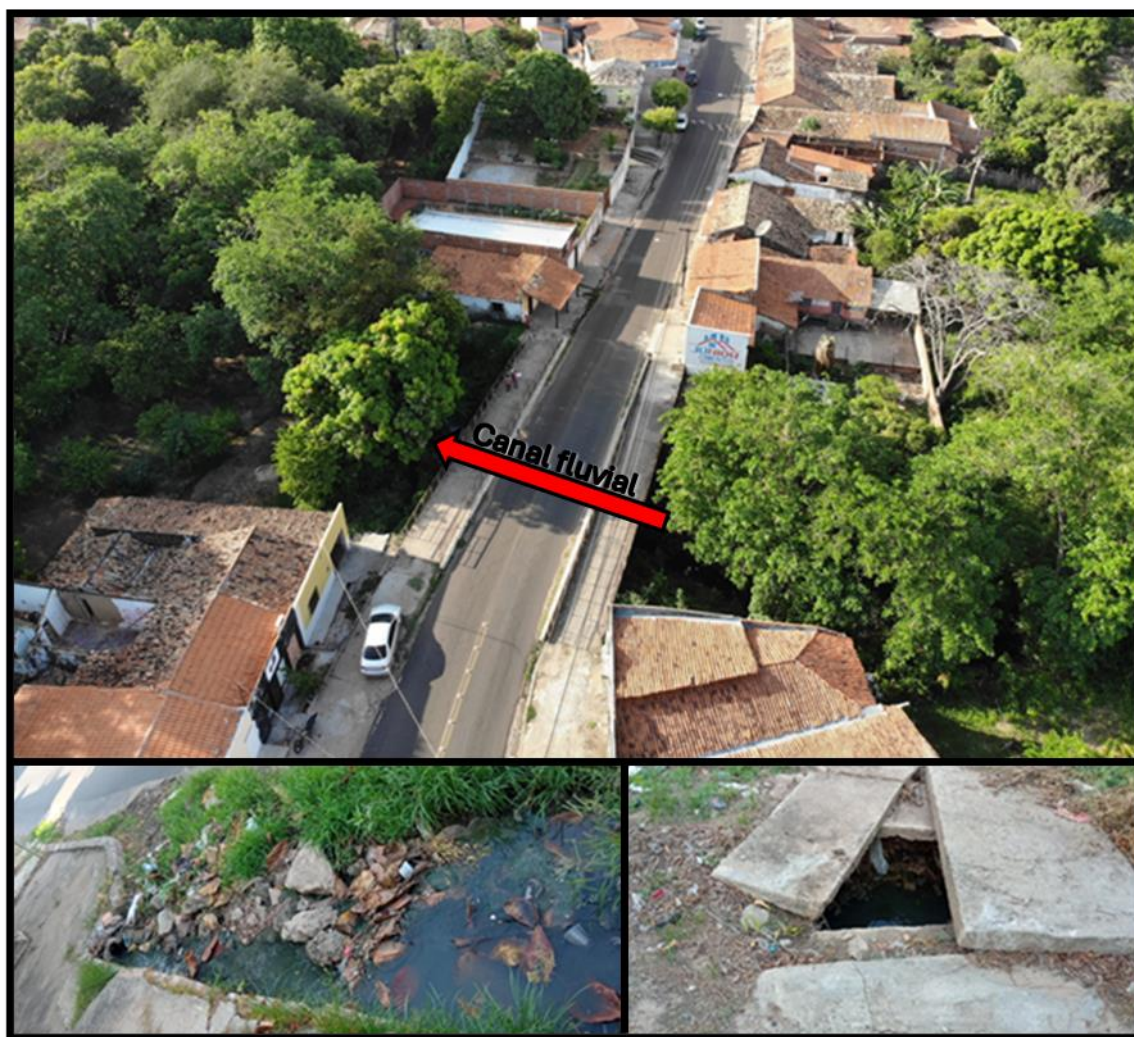
Figura 24: Ponte de concreto em cima do canal principal e esgoto a céu aberto Fonte: Fotografada pela autora (2021).
