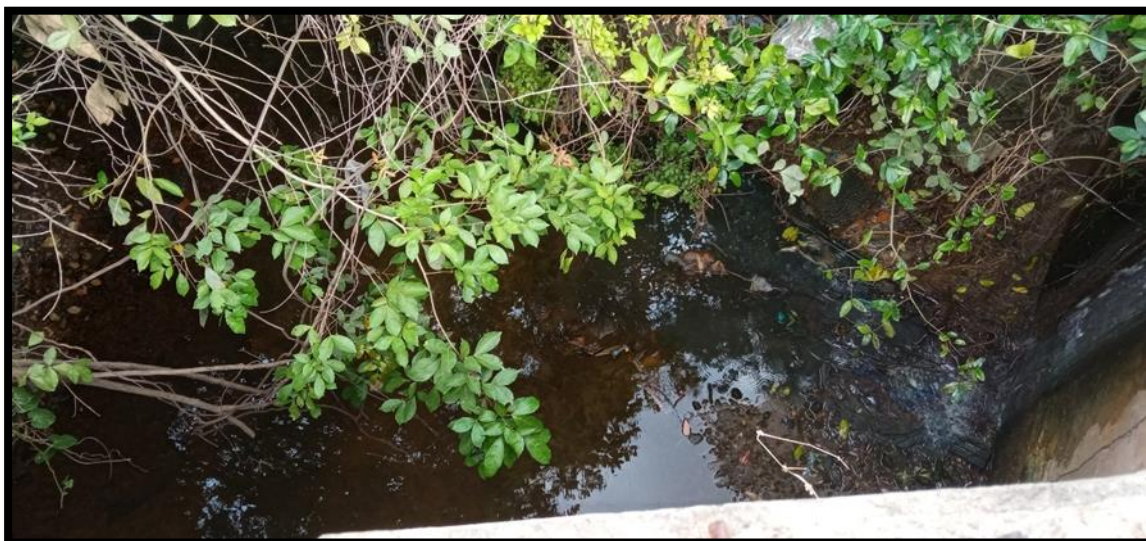
Figura 12: Descarga de esgoto diretamente no canal principal
