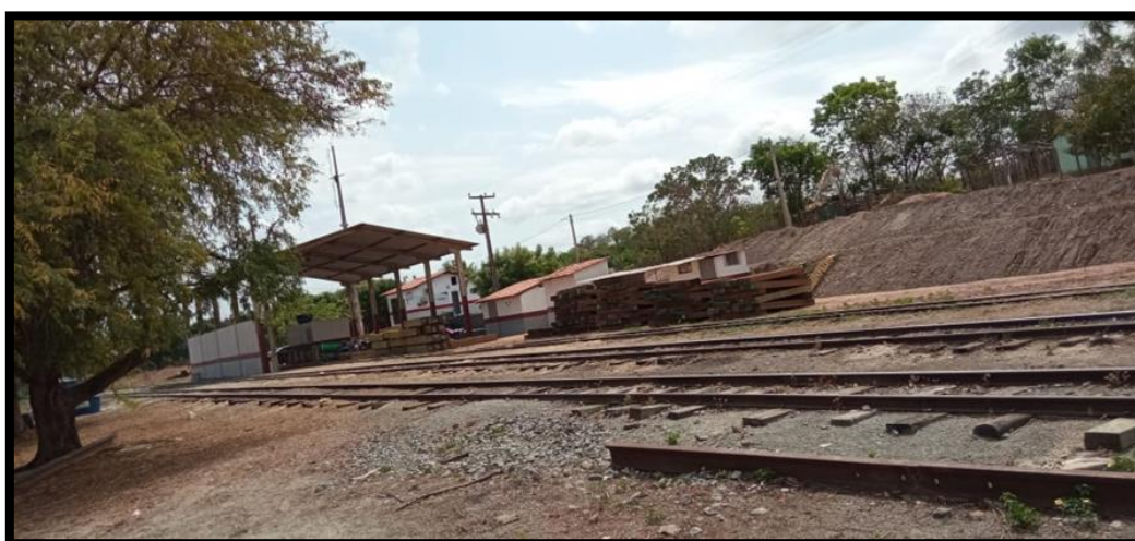
Figura 9: Linha férrea transnordestina, a jusante do ponto 2
