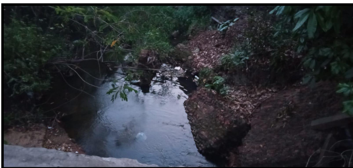
Figura 17: Ponto 6, jusantes da ponte
