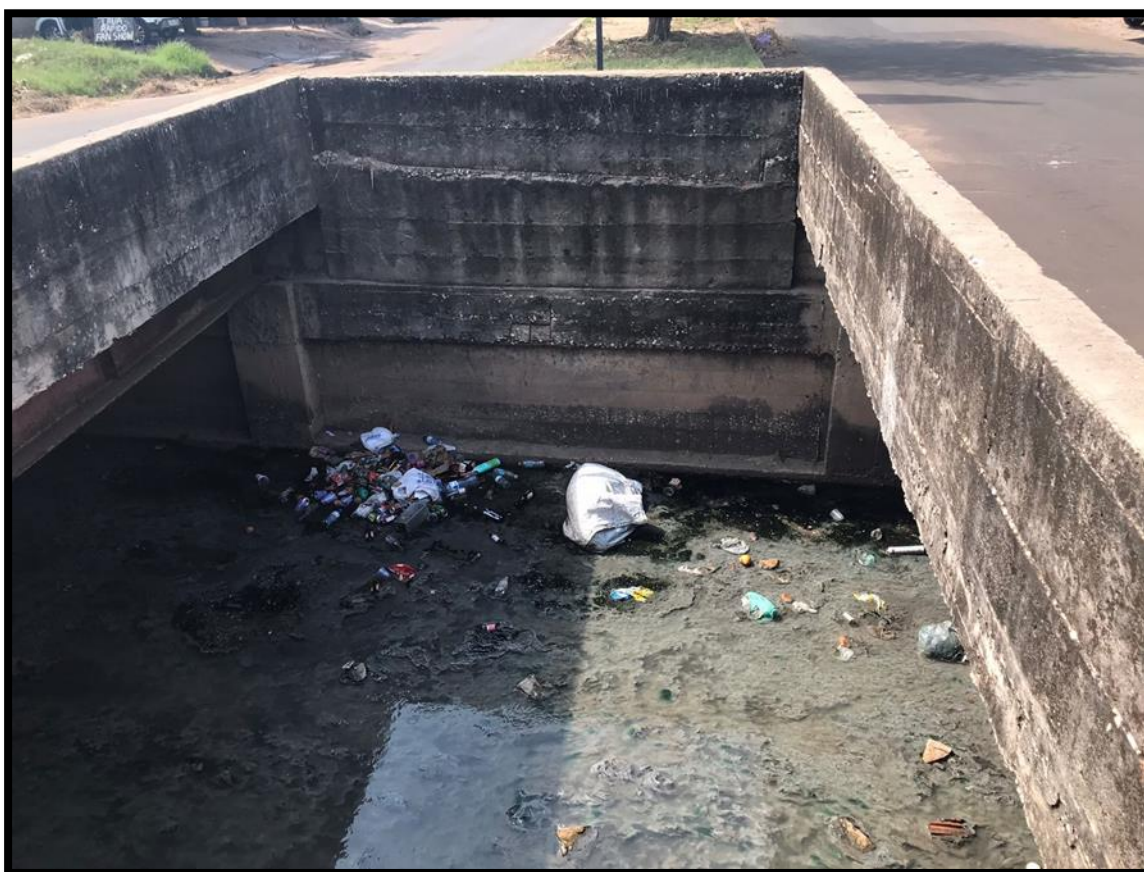
Figura 34: Canal 5, Avenida Edson Lobão
