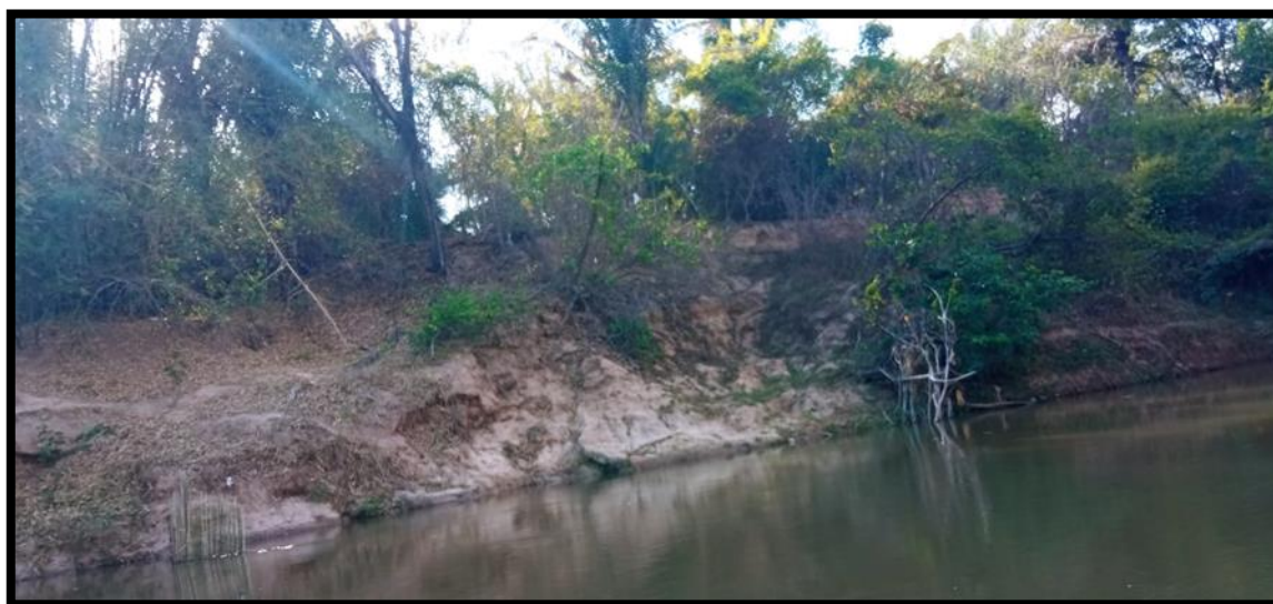
Figura 14: Erosão na margem esquerda do rio Itapicuru compartimento (IV)
