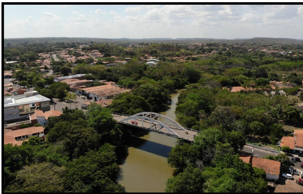
Figura 26: Ponte Nereu Bittencurt sobre o rio Itapecuru.
