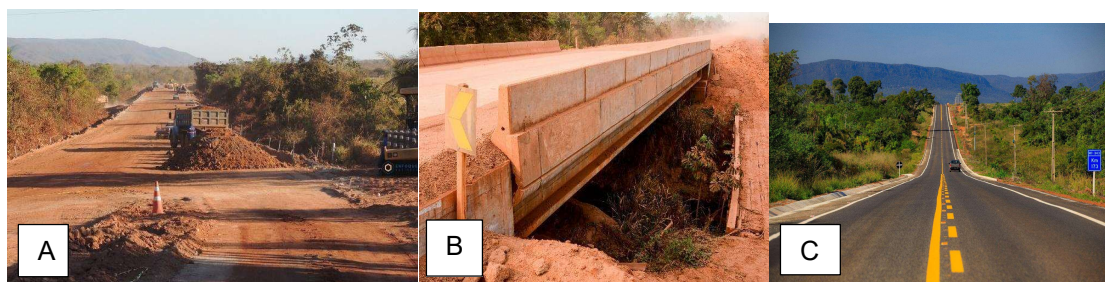
Figura 16: Obras da pavimentação asfáltica e ponte na MT-343, entre os municípios de Cáceres e Porto Estrela, Mato Grosso. Fonte: (A) Roberto (21/10/2020); (B) Secretaria de Estado e Infraestrutura e logística (29/03/2021); (c) Secom (24/06/2022).
