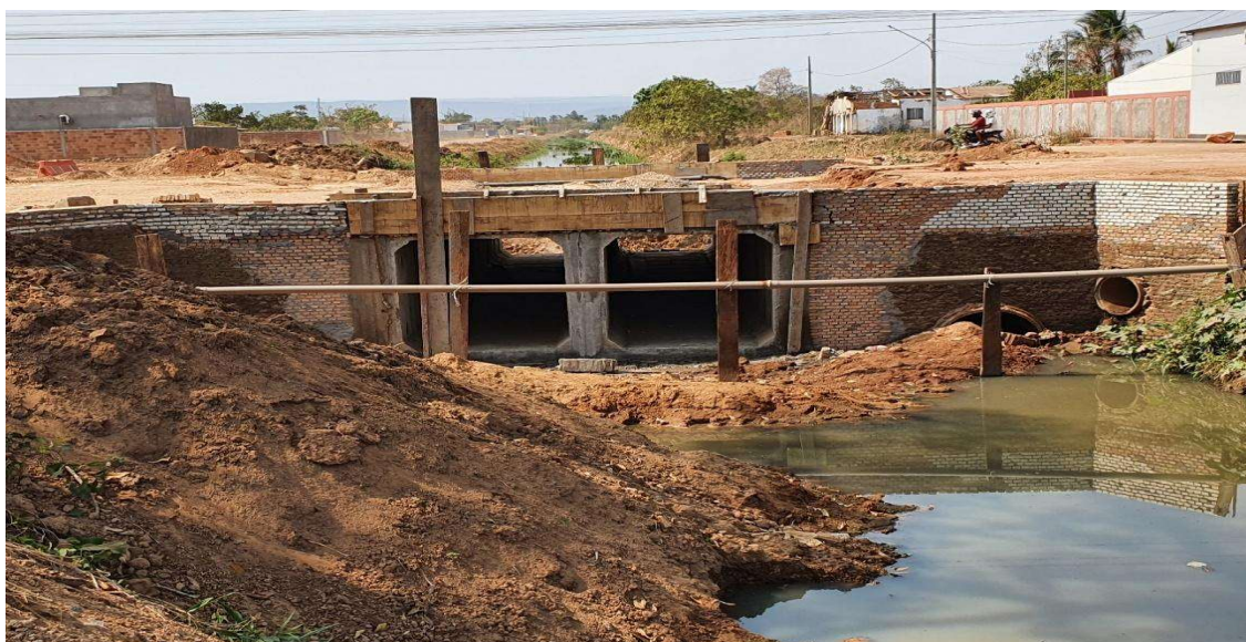
Figura 21: Obra de construção de ponte sobre o córrego Fontes, na cidade de Cáceres, Mato Grosso. Fonte: A autora (2023) Sub-bacia Fontes.
