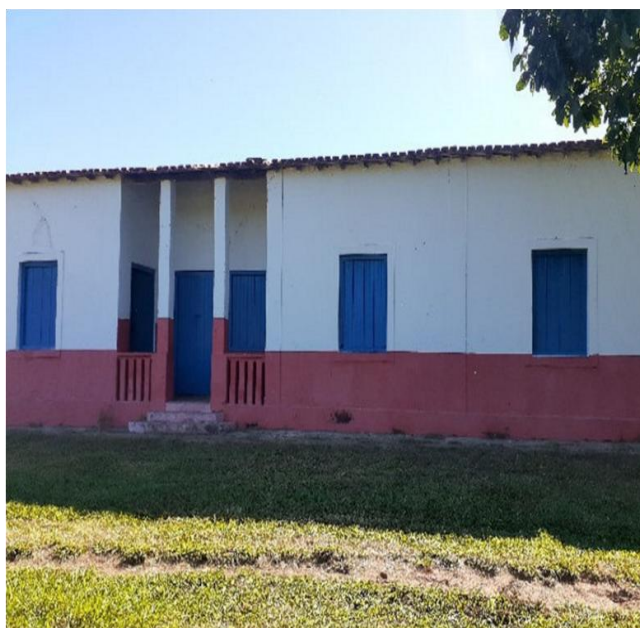
Figura 4: Imagem da fachada da Escola Otaviano Calmon
