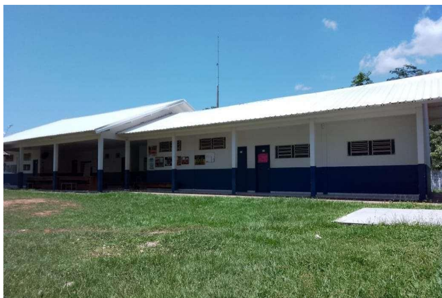
Figura 10: Fachada frontal da nova unidade escolar Julia Pare
