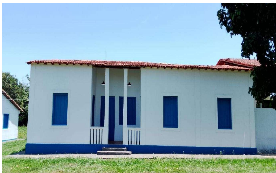
Figura 4: Fachada frontal da escola Otaviano Calmon
