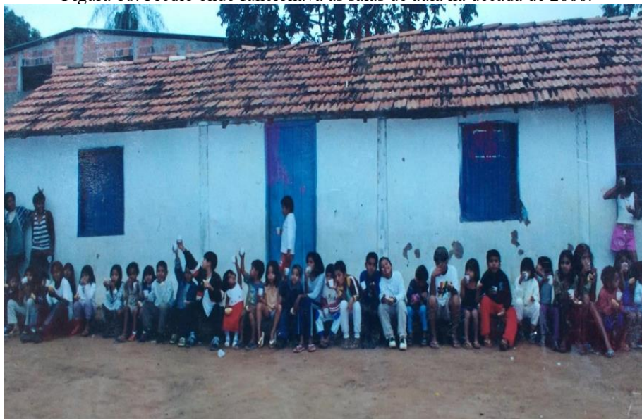
Figura 18: Prédio onde funcionava as salas de aula na década de 2000.
