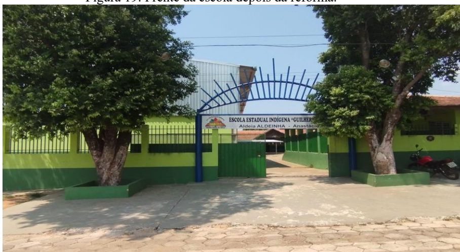
Figura 19: Frente da escola depois da reforma.
