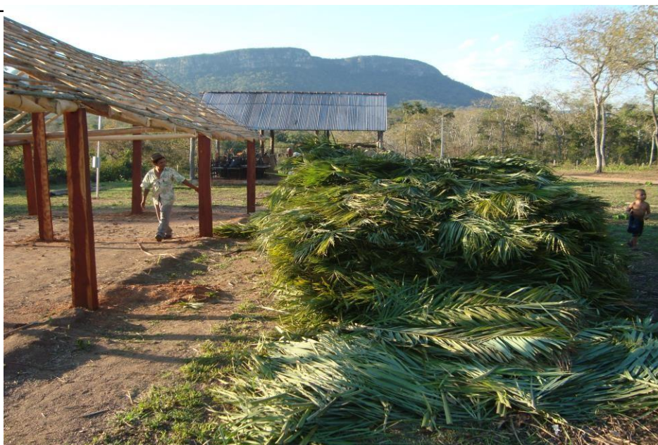
Figura 05 – Construção da primeira escola no Polo Central
