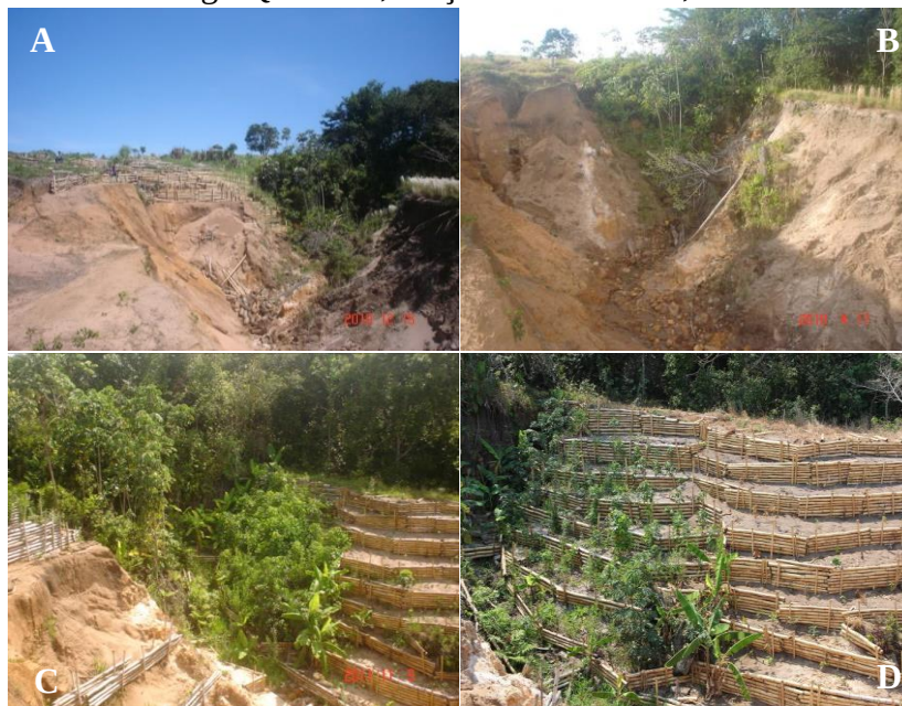
Figura 04 – A e B - leito principal da Voçoroca da Parede; C e D - atividades de corte/aterro. Bacia do Córrego Queixada, Voçoroca da Parede, Reserva do Cabaçal/MT.
