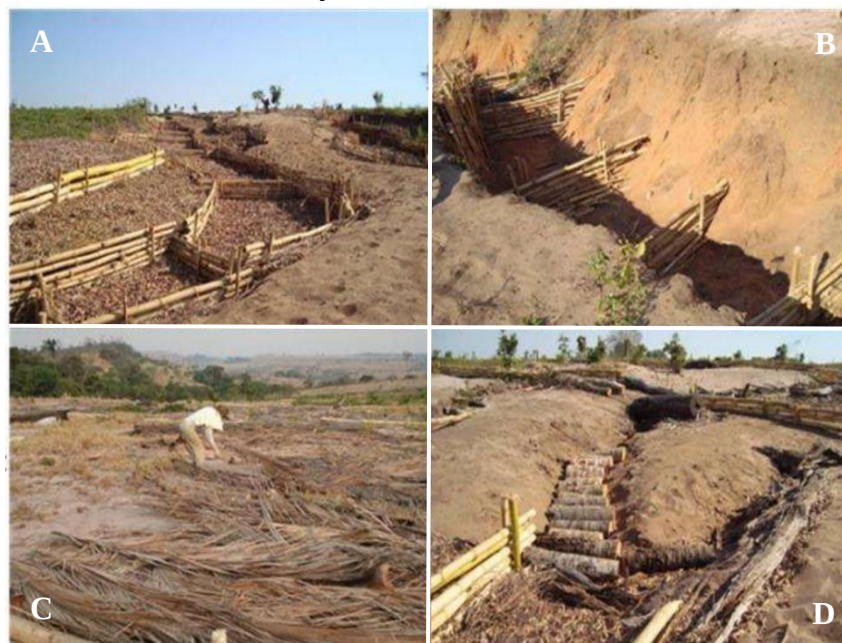
Figura 03 - A e B – Paliçadas laterais ( Bambusa sp. ); C – Folhas de coqueiro ( Orbignia sp. ) cobrindo o solo; D – Paliçadas de troncos de coqueiro. Bacia do Córrego Queixada, Voçoroca da Parede, Reserva do Cabaçal/MT.
