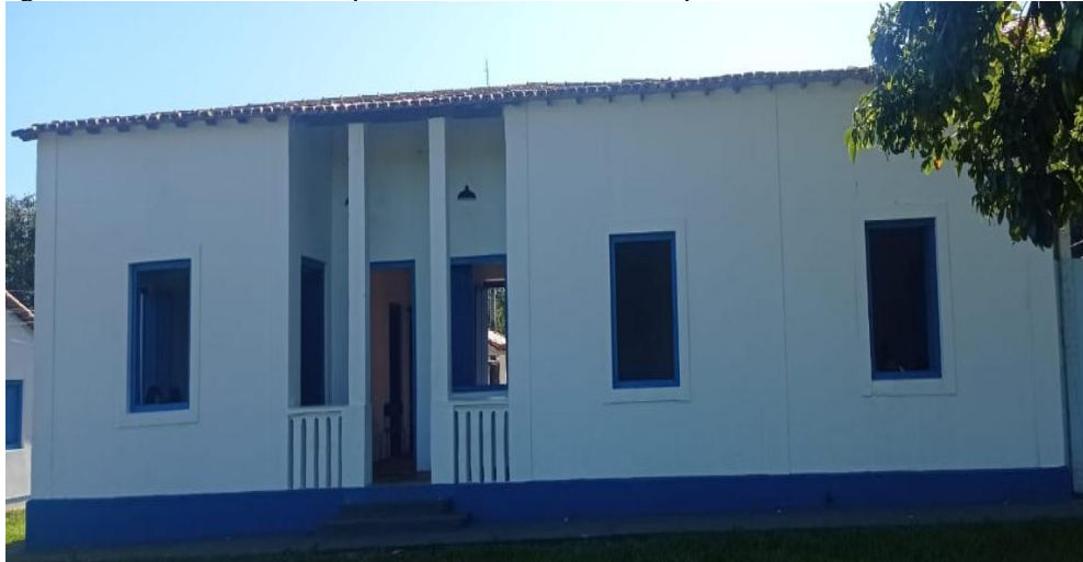
Imagem 12 – Vista de frente do prédio da Escola construída pelo SPI e reformada no ano de 2023
