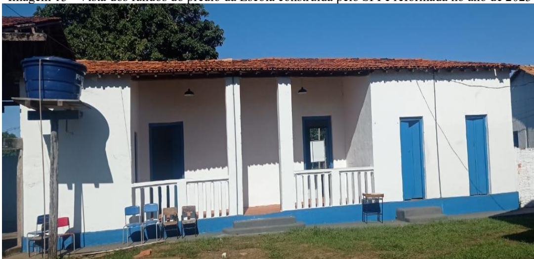
Imagem 13 - Vista dos fundos do prédio da Escola construída pelo SPI e reformada no ano de 2023
