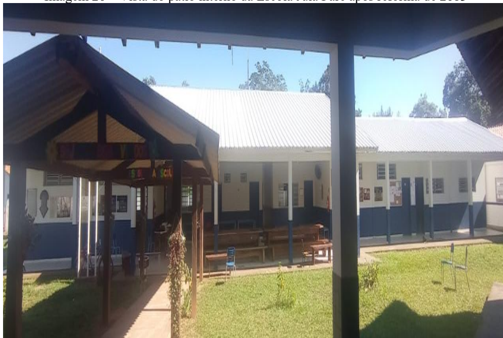
Imagem 20 – Vista do pátio interno da Escola Julia Pará após reforma de 2013
