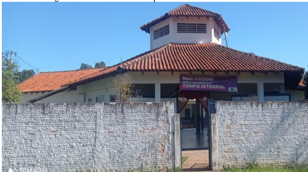
Imagem 17 – Vista da Entrada do prédio da Escola na Aldeia Umutina
