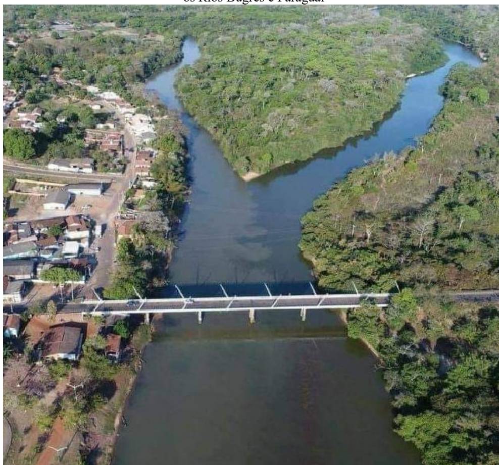
Imagem 3 – Vista aérea de parte da cidade de Barra do Bugres tendo ao fundo a ilha Território Balatiponé entre os Rios Bugres e Paraguai
