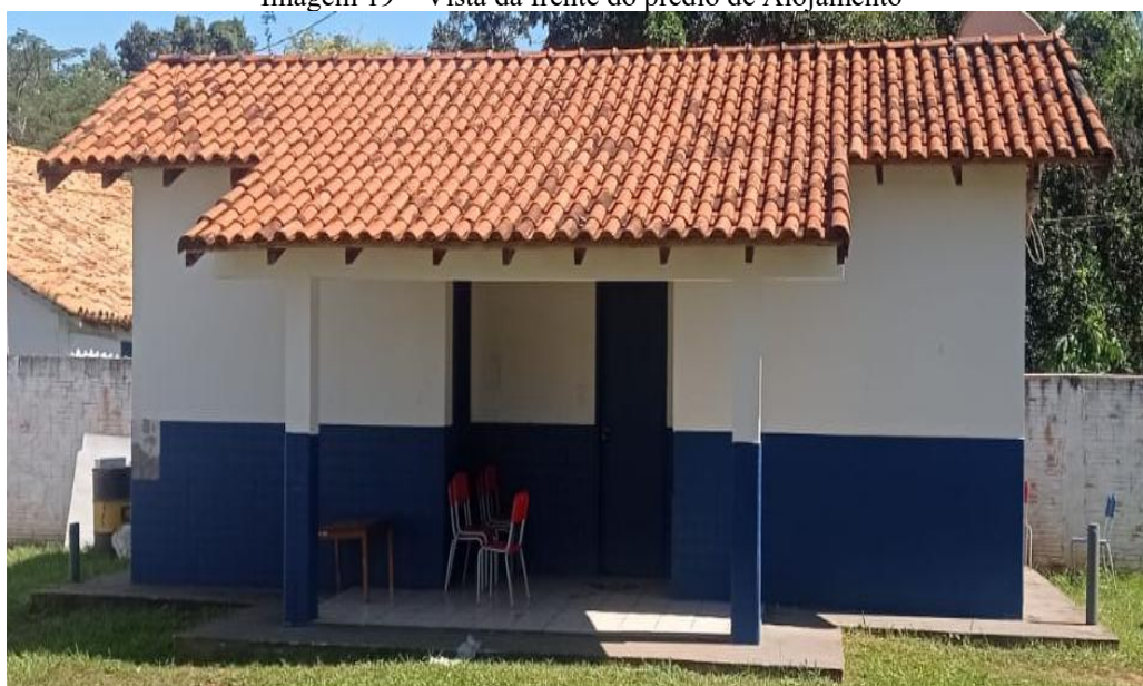
Imagem 19 – Vista da frente do prédio de Alojamento
