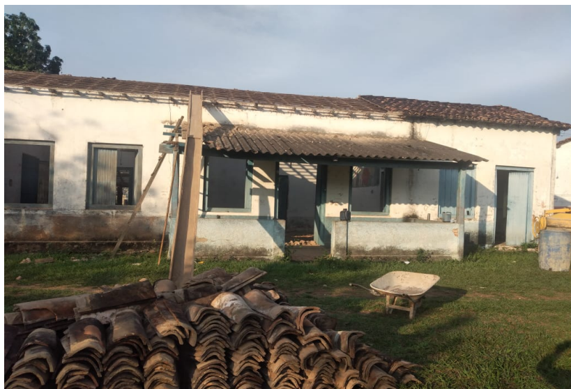
Figura 6 - Restauração da Casa Grande
