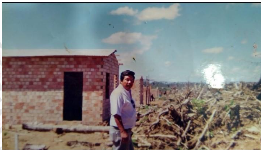
Figura 12 – Construção das casas da aldeia Kopenoty
