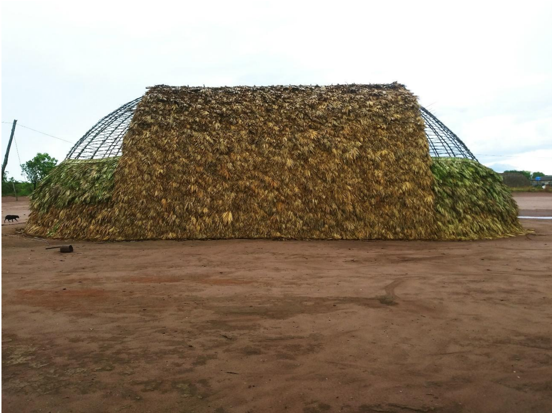
Figura 21 – Cobertura da Hati com palha de guariroba
