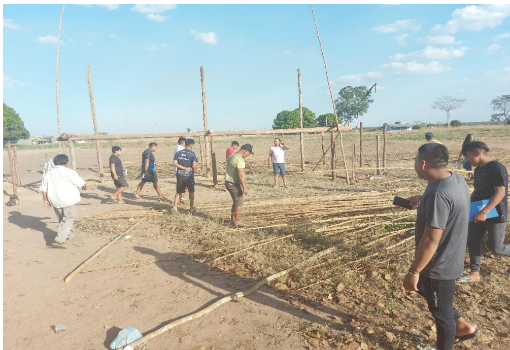
Fig. 5: Os alunos também fizeram visita in loco da segunda Hati que estava sendo construído, ainda na fase inicial.
