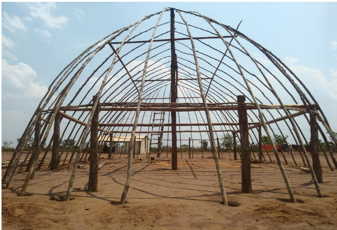
Figura 10 – O resultado final da colocação dos caibros (arco)
