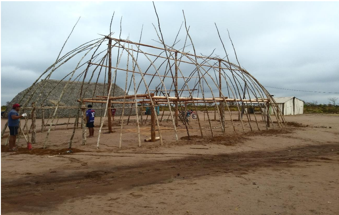
Figura 9 – Montagem da casa
