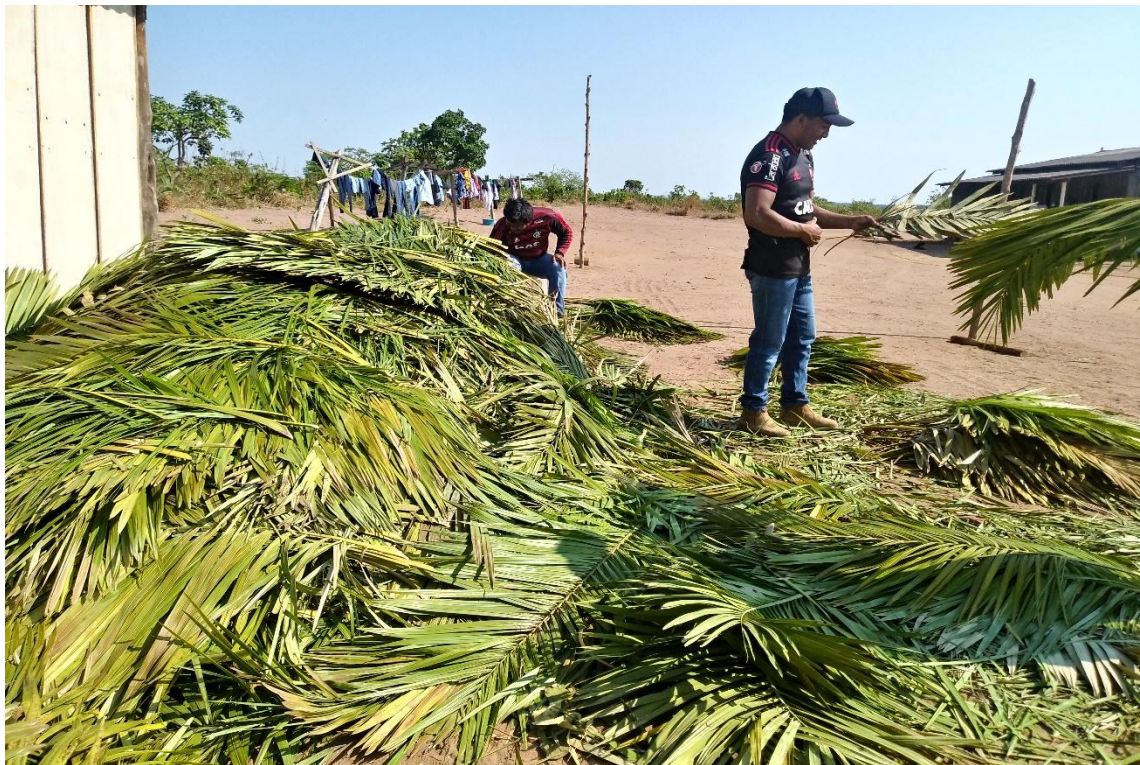
Figura 16 – Preparo da palha para a cobertura da Hati
