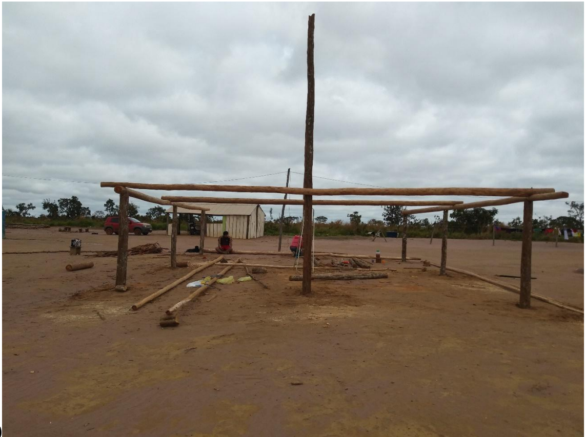
Figura 7 – Erguimento inicial da Hati (colocação dos esteios principais e laterais da
