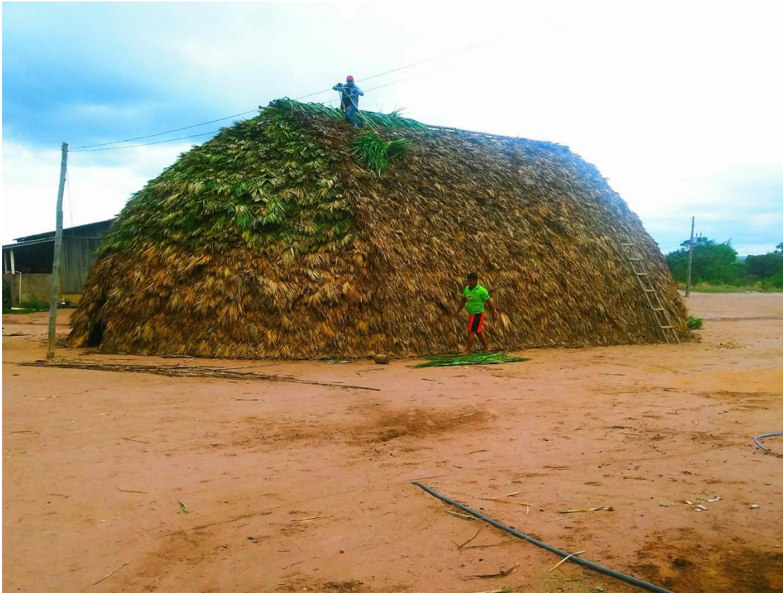
Figura 22 – Cobertura da Hati quase sendo finalizada
