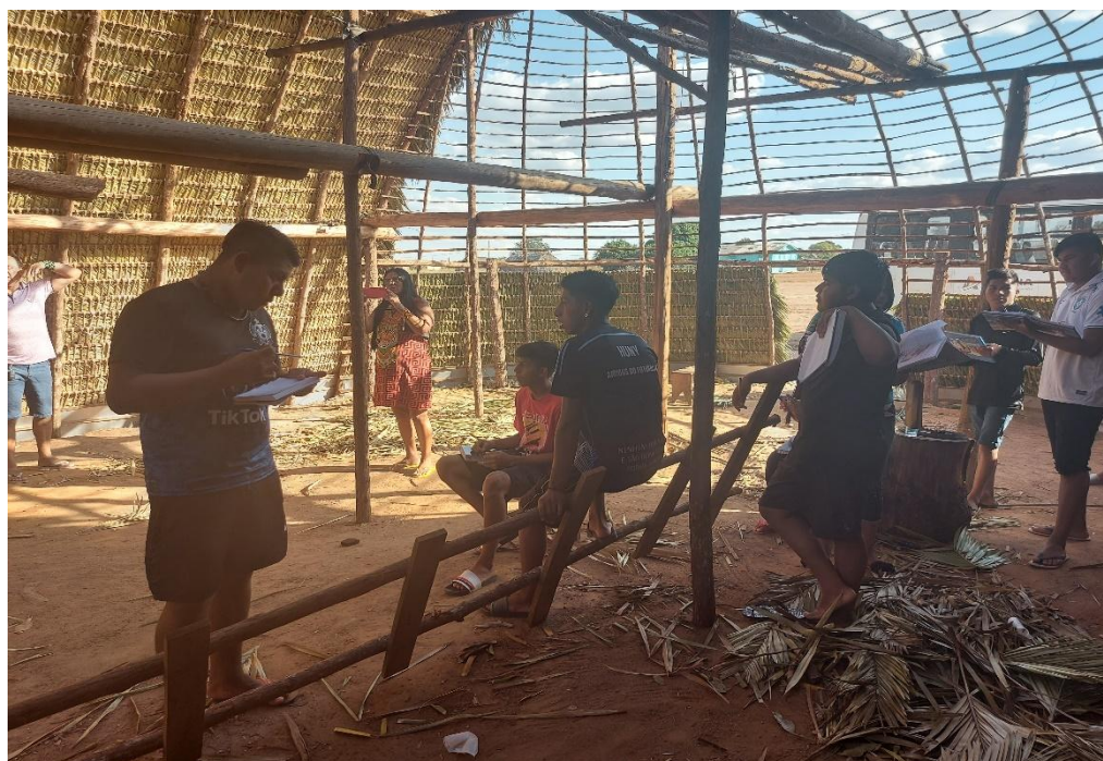
Fig. 3: visita in loco as construções da Hati
