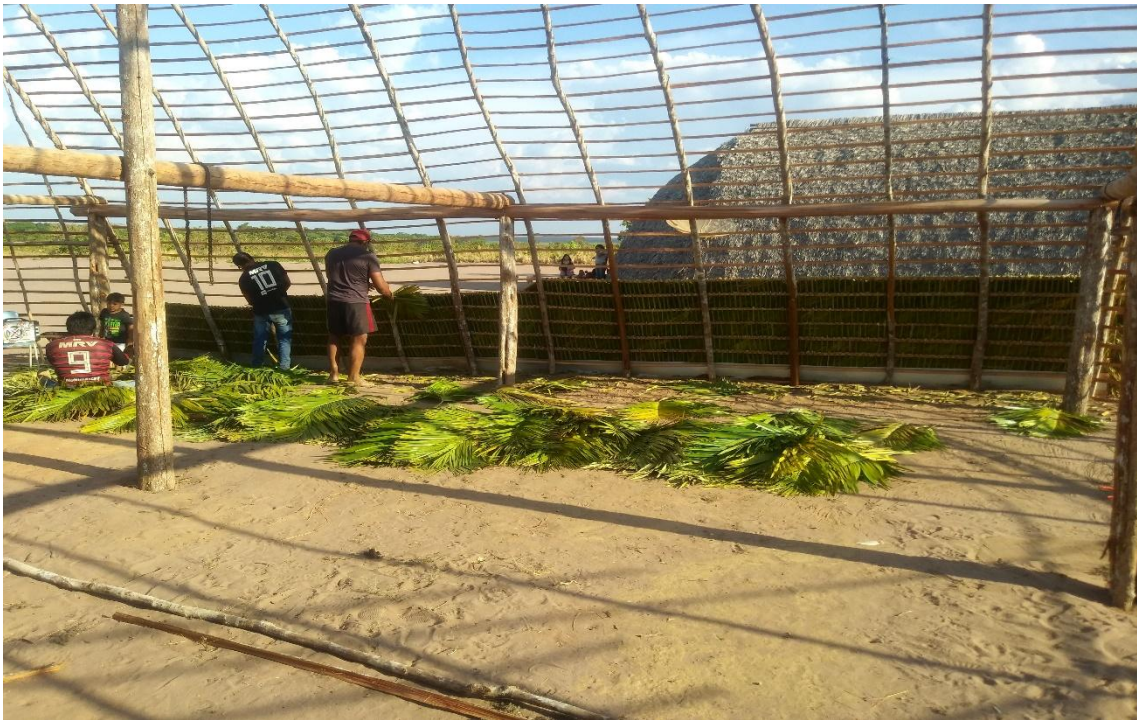
Figura 20 – Início da cobertura da Hati com palha de guariroba
