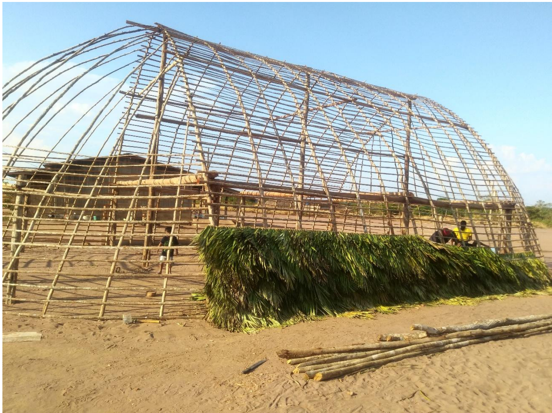
Figura 18 – Preparo da palha de guariroba finalizado para a cobertura
