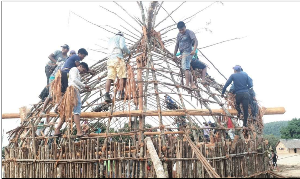
Figura 21: Como se constroe Takãra rakopi'ã
