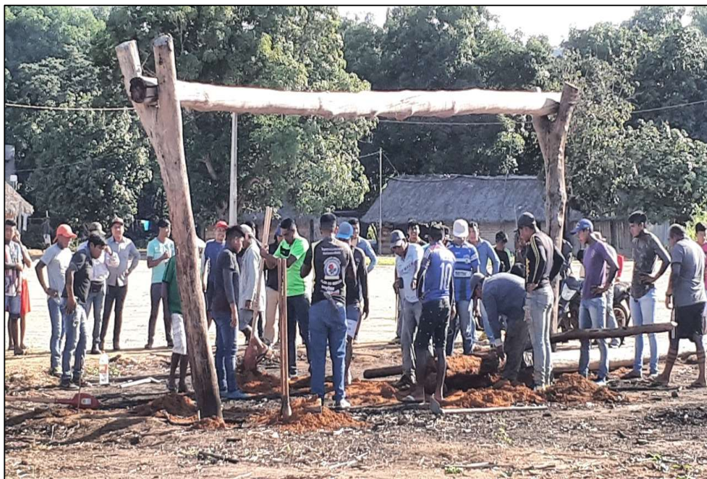
Figura 22 – Estrutura básica da Takãra: Ywrayjoo e Xorao
